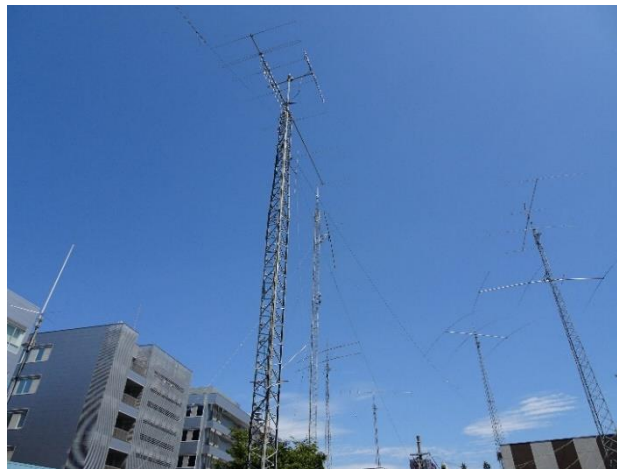
図 3 片平部室の八木・宇田アンテナ
