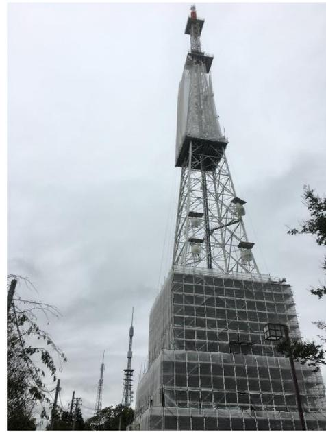
図5 地上デジタル放送の送信アンテナ
